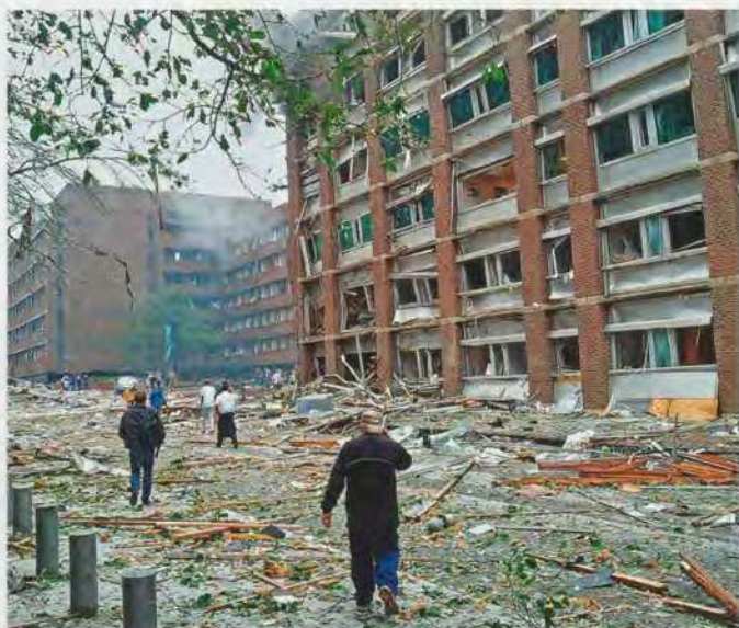
Förödelse i Oslo efter explosionen den 22 juli. Huset till höger innehöll premiärminister Jens Stoltenbergs kontor.
