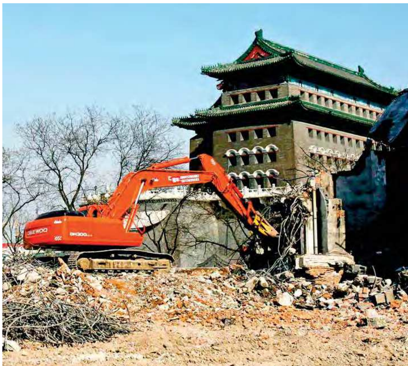
Ut med det gamla! Rivningsarbete i Peking.
