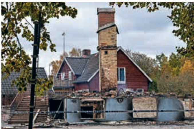
Nedbränd flyktinganläggning i Kåna.
