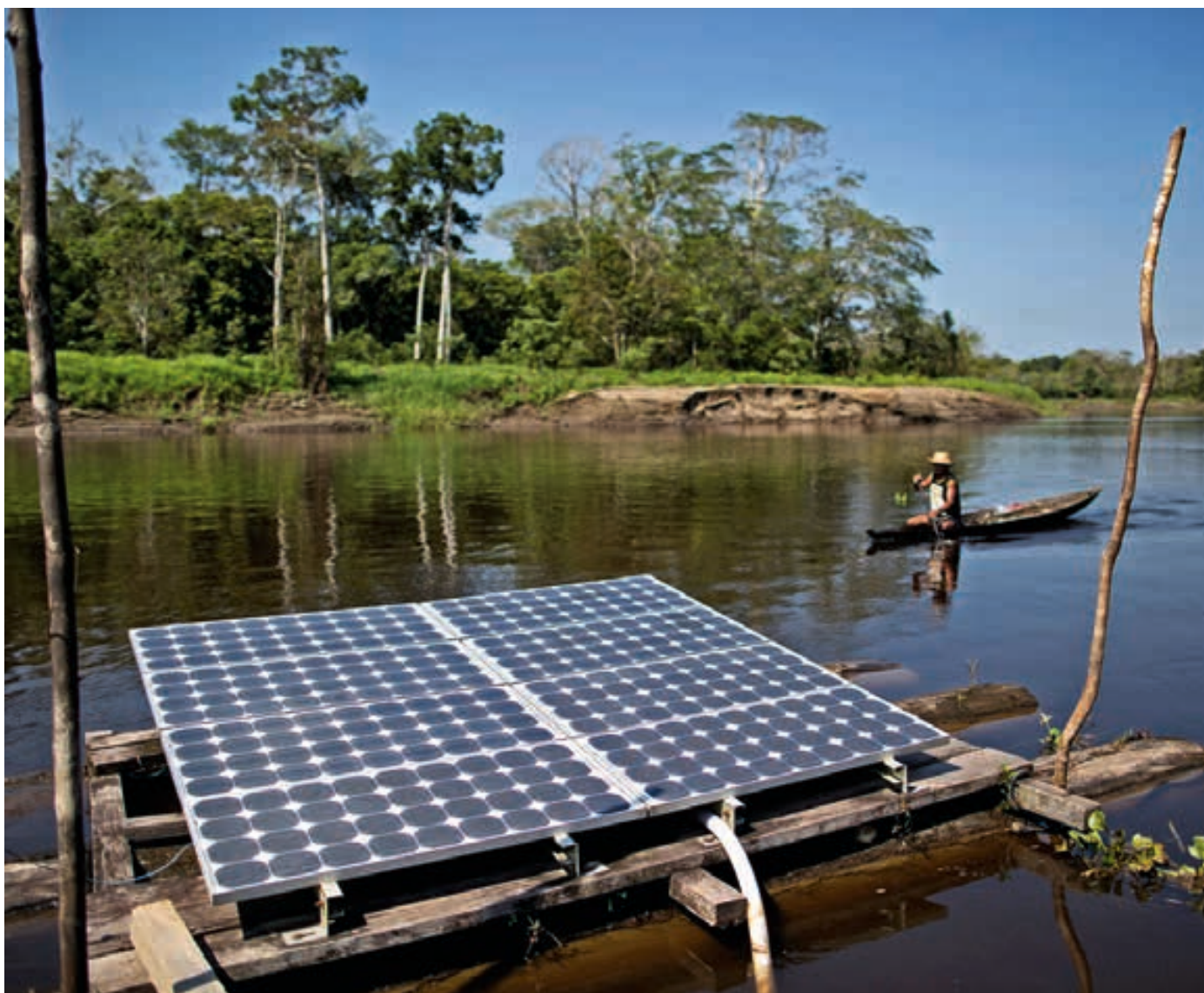
Hightech i Amazonas: Solpaneler driver pumpar som ger vatten till innevånarna i Vila Nova do Amana.
