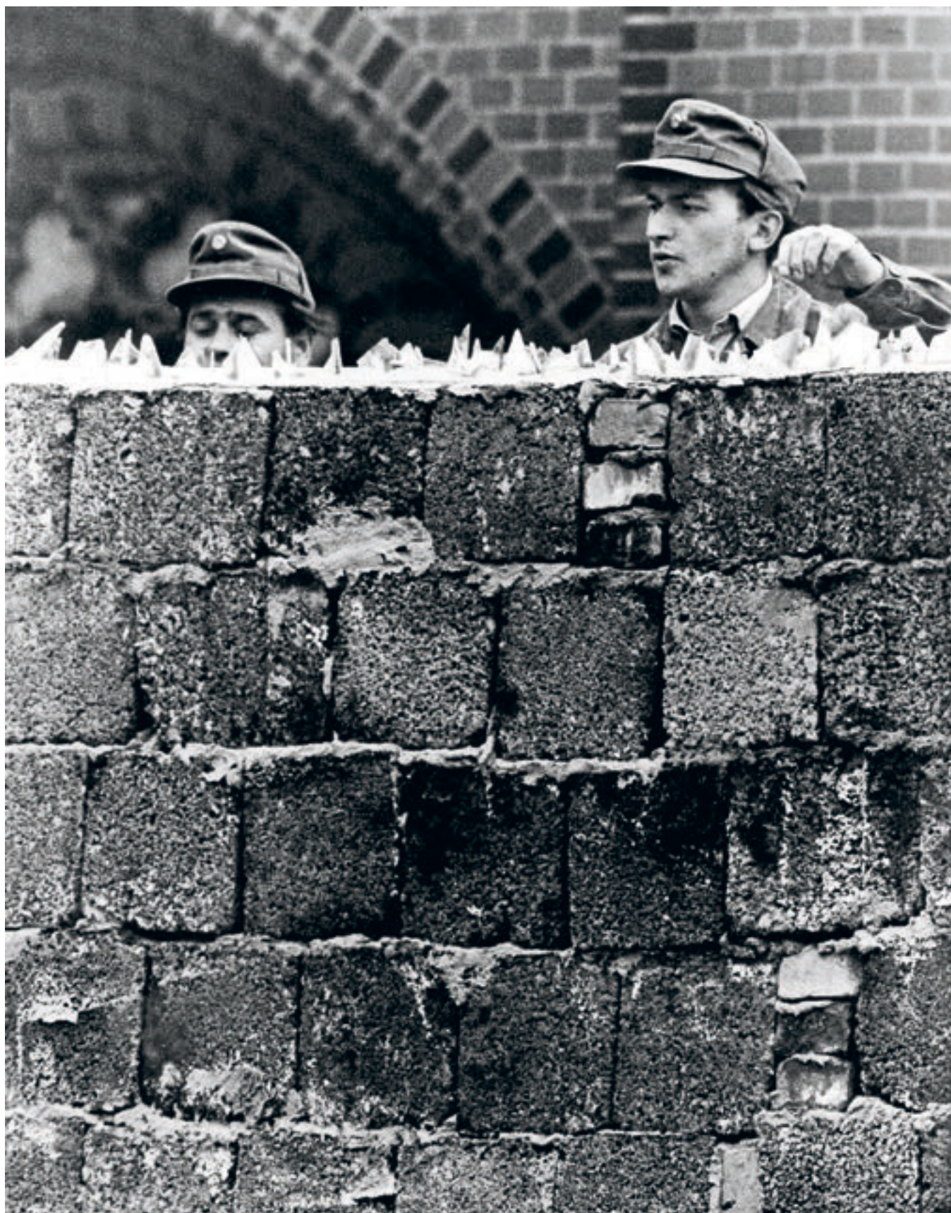
Muren som delade en stad.
