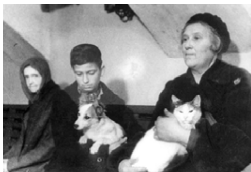
Tröst i skyddsrummet under andra världskriget.
