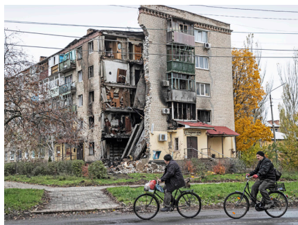
Återuppbyggnadsarbetet blir massivt.
